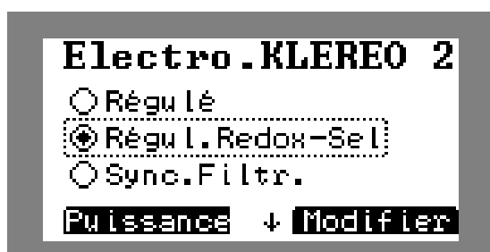
Figure 52. Réglage de la puissance de fonctionnement de l'électrolyseur
